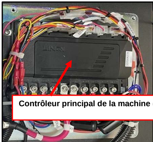
Contrôleur principal de la machine (EB1)
